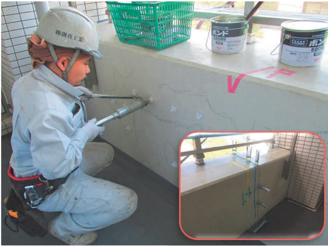
コンクリート割れ・浮き補修工事 部位別に応じて適切な補修工法を選定し 再発防止に取り組めます。
