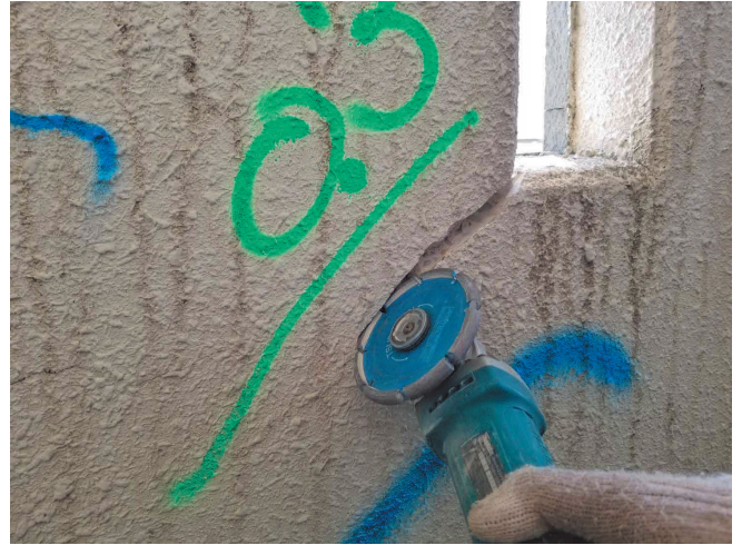
コンクリート割れ・浮き補修工事 部位別に応じて適切な補修工法を選定し 再発防止に取り組めます。
