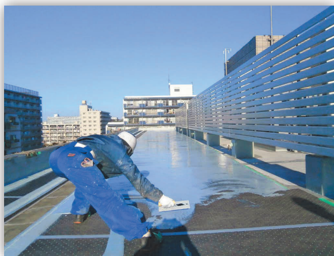
ウレタン塗膜防水 密着工法・通気緩衝工法・複合法
