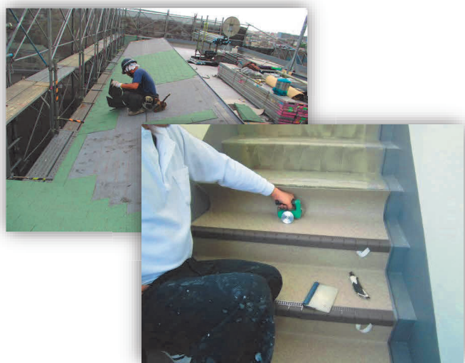
その他各種防水工事 屋根シングル葺き・防滑塩ビシート ゴムシート防水・各種止水工事
